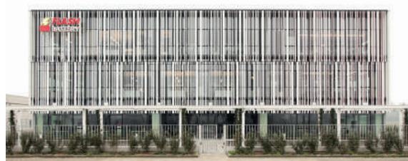
La sede di Flash Battery a Sant'Ilario d'Enza (RE) si sviluppa su una superficie complessiva di 7.000 metri quadri grazie al recente completamento del nuovo building da 2.200 metri quadri, ma è già stato acquistato il terreno che ospiterà la terza fase di ampliamento
